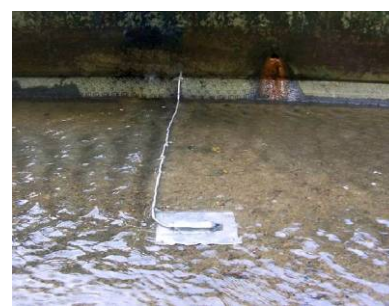
超音波式流速計 （底面設置）
