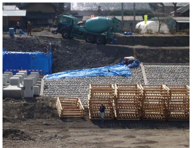
写真-1 取付け部の現地施工状況写真
