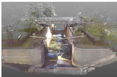
石井閘門の全体を示す図面は、明治期に作成された構造図のみであったことから、3Dレーザー測量を実施し、調査・設計の基礎となる図面を作成
