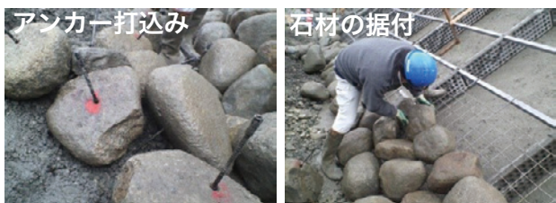
写真-7 背面アンカー一体護岸施工イメージ
