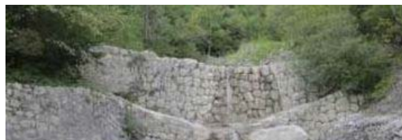
図-2 マニバル溪（フランス）の砂防堰堤（1896 年施工、2014 年著者撮影）
