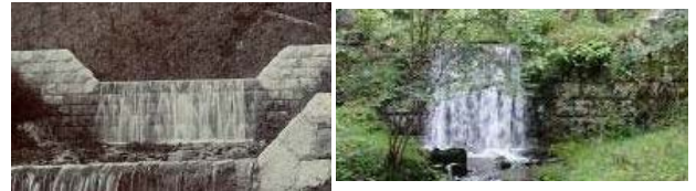
図-11 ハビロ沢（東京都水道水源林）の堰堤（1916年施工）、（左：堰堤竣工時状況（諸戸北郎博士アルバム写真より） 右：2014年撮影）
