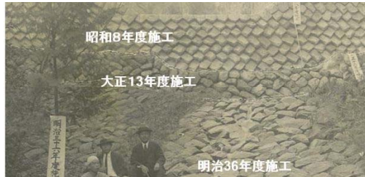
図-10 逆瀬川の砂防堰堤（兵庫県砂防課提供）
