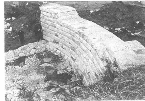
写真5 東京都水道水源林の大正5年 施工堰堤 (諸戸北郎博士アルバムより)
