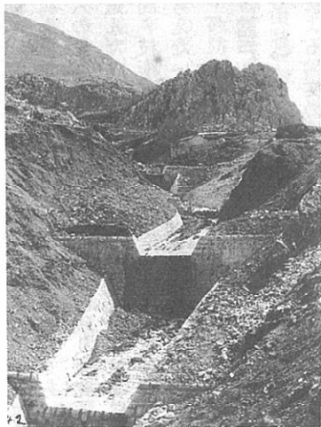
写真 2 モンテネグロ・クリマルリュ博 溪の砂防堰堤（諸戸北郎頃 士アルバムより、1910年頃）
