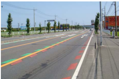
路面標示による誘導
