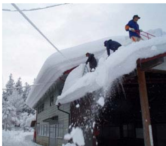
人力による雪下ろし作業
