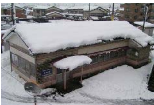
屋根に降り積もった雪(東岩瀬駅: 富山市西宮字中稲割)
