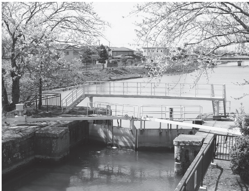
写真3 石井閘門（閘尾部側 撮影：2013年4月）
