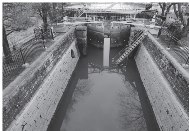
写真2 水替え時の全景（閘尾部側、撮影：2013年2月）
