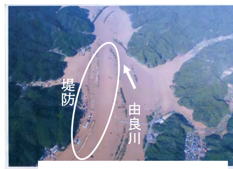
写真 1 浸水状況と堤防
