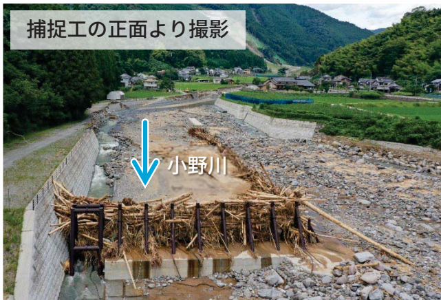
捕捉工上流側の橋梁地点における流木の撤去作業状況
