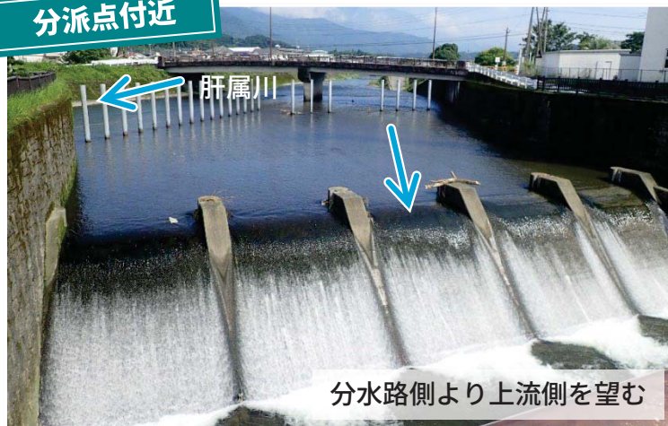
分水路入口部
