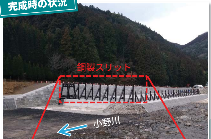
流木捕捉工（貯木地・鋼製スリット等） 模型の最終形状
