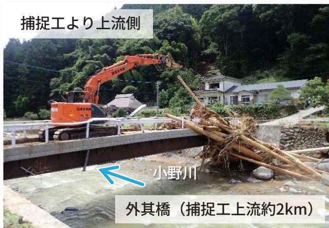
捕捉工上流側の橋梁地点における流木の撤去作業状況
