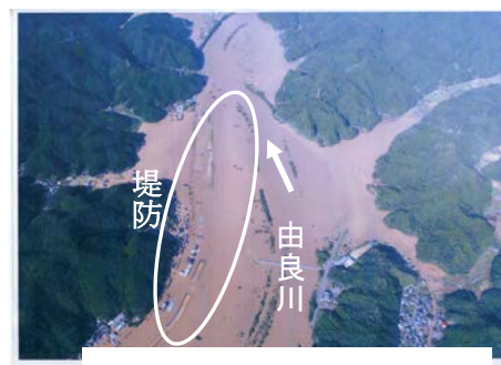
写真 1 浸水状況と堤防
