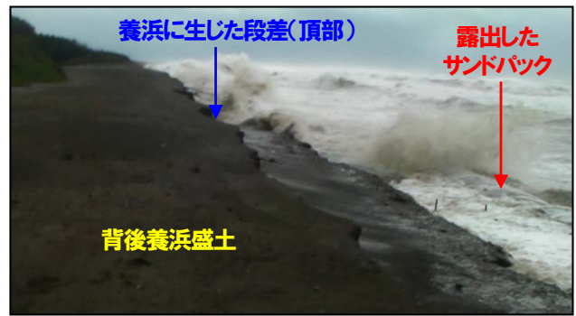
写真-3 1411号通過時の波の遡上状況(2014年8月9日18時頃)
