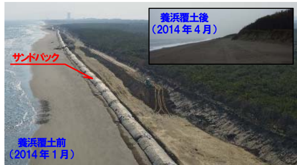
写真-1 埋設護岸の設置状況
