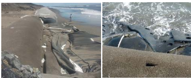
写真-4 サンドバックおよび洗掘防止工の変状例
