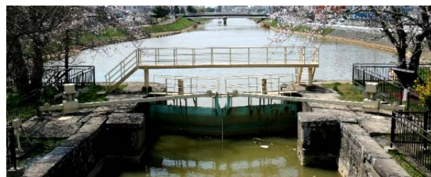
写真-1 石井閘門（閘尾部）の全景 H25.4撮影
