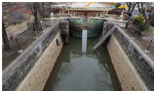
写真-3 水抜き調査状況 (H25. 1撮影)
