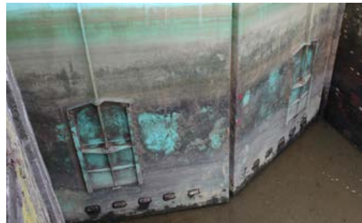
写真-6 今回の水抜き時に確認された小窓（H25.1撮影）
