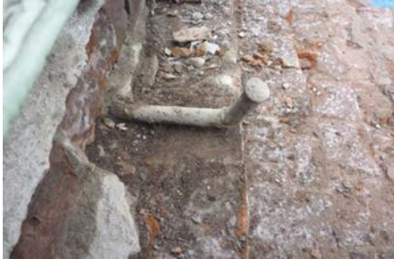
写真-8 石井閘門の笠石下部から見つかったズレ止め金具 この金具は健全であるが一部の金具は腐食が進んでいた
