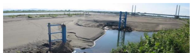
図-2 平成 23 年台風 15 号の土砂堆積状況
