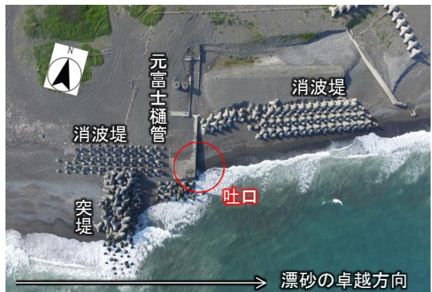
写真-2 元富士樋管空撮(平成29年4月撮影)
