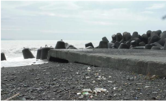
写真-3 台風21号来襲後の状況(平成29年10月24日撮影)
