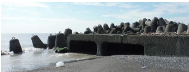
写真-1 元富士樋管吐口(平成29年10月18日撮影)
