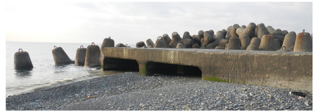
写真-1 元富士樋管吐口(平成31年1月30日撮影)
