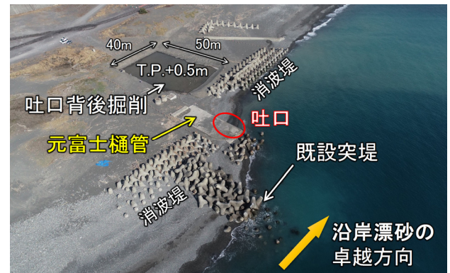
写真-2 元富士樋管空撮(平成31年1月30日撮影)
