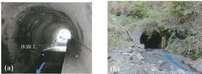
図-9 トンネル内部の床固工(a)とトンネルの入口の現況(b) (2017年10月著者撮影)
