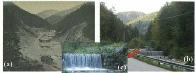
図-3 ラングバート溪の砂防工事の1910年頃(a)と現況(b)(c)((a)諸戸アルバムより、(b)(c)2012年、著者撮影) Fig. 3 Langbaht torrent in around 1910(a) and in 2012(b)(c)((a) From Moroto's photos album, (b)(c) Taken by author)
