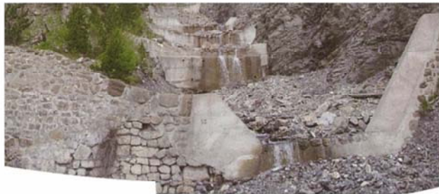
図-13 サニエル溪の1897年施工の砂防堰堤(2004年著者撮影)
