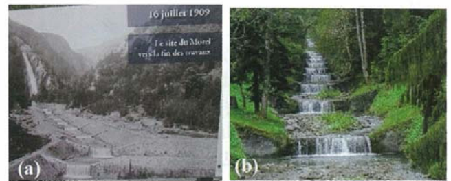
図-11 トンネル吐口の滝下より下流の流路工の1909年当時(a)と現況(b) ((a)現地展示説明資料を2017年9月著者撮影, (b)2017年10月著者撮影)
