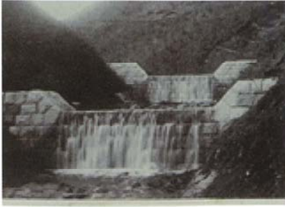
図-26 東京都水源林内にある1916年施工の堰堤 (諸戸アルバムより)
