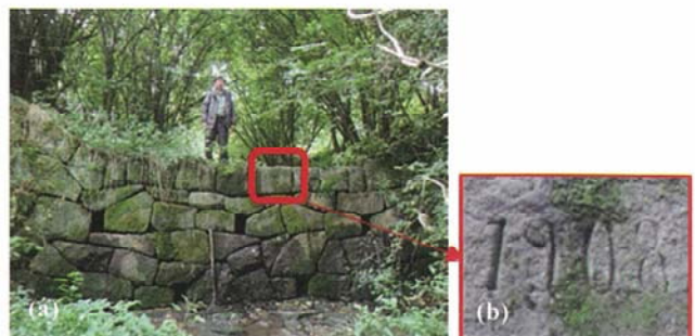
図-21 ブランドスキー支溪の石積堰堤の現況(a)と堰堤天端の石材((a)の枠部分)に刻まれた4桁の数字「1908」(b)(2017年10月著者撮影)
