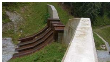
図-7 鋼材部分が堤体上流へ出た堰堤
