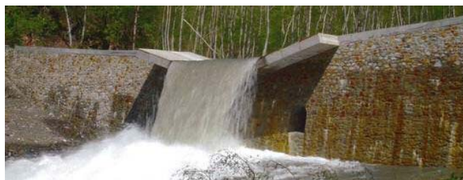
図-10 水通し部全体に庇を設置
