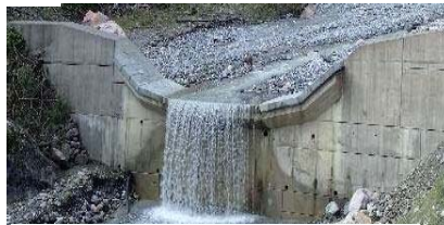
図-12 水通し部中下段に庇を設置
