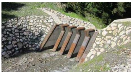
図-4 砂防堰堤の基本的構造（4）より
