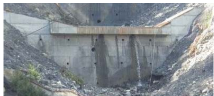
図-11 水通し部底部のみに庇を設置
