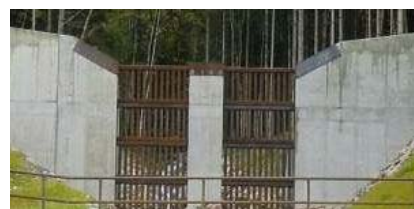
図-8 鋼材部分が堤体内にある堰堤
