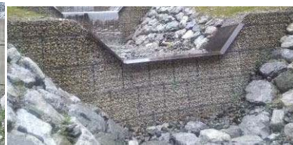
図-13 水通し部中下段に庇を設置
