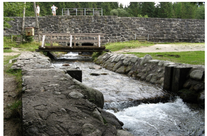
図-7 現況堰堤の左岸袖部と水路
