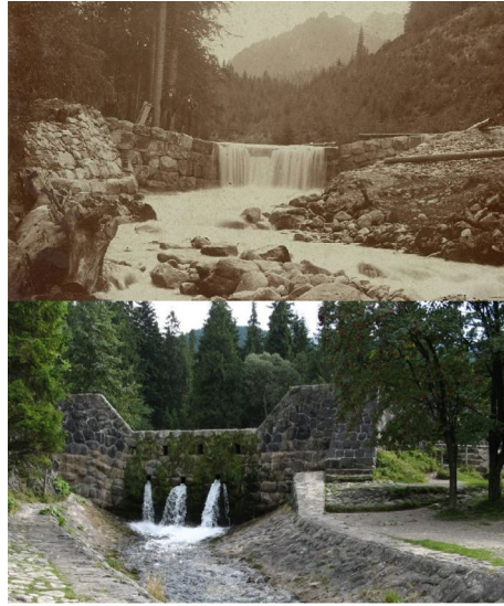
図-1 ビストラ溪の砂防堰堤 (上：諸戸写真、下：現況写真)
