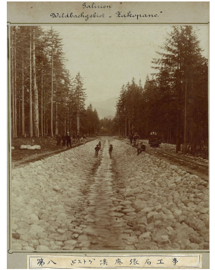
図-2 諸戸の写真にある砂防堰堤下流に施工された底張石工
