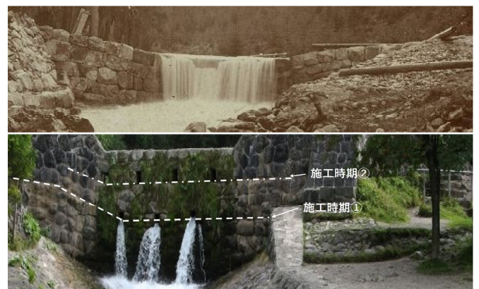
図-6 砂防堰堤の石積形状
