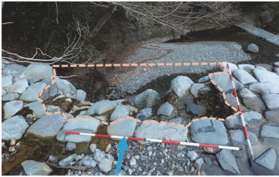
図-14 栗ノ木平堰堤 (2016 (平成 28) 年 3 月撮影) Fig.14 Kurinokitaira check dam (Taken in 2016)
