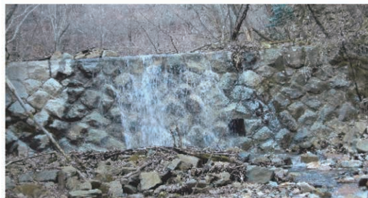
図一六 白水沢第 1 号堰堤 (2016 (平成 28) 年 3 月撮影) Fig.6 Siramizusawa No. 1 check dam (Taken in 2016)
