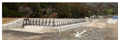
図-22 R3.2現地状況 (透過部)
