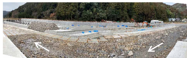
図-23 R3.2現地状況 (流入部)
