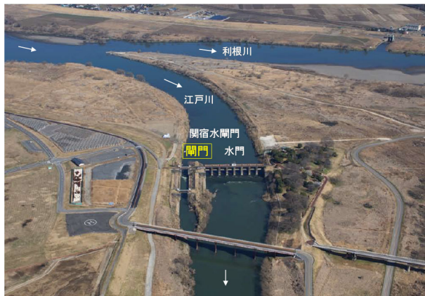
図-1 江戸川流頭部の状況 (H30.3撮影)
