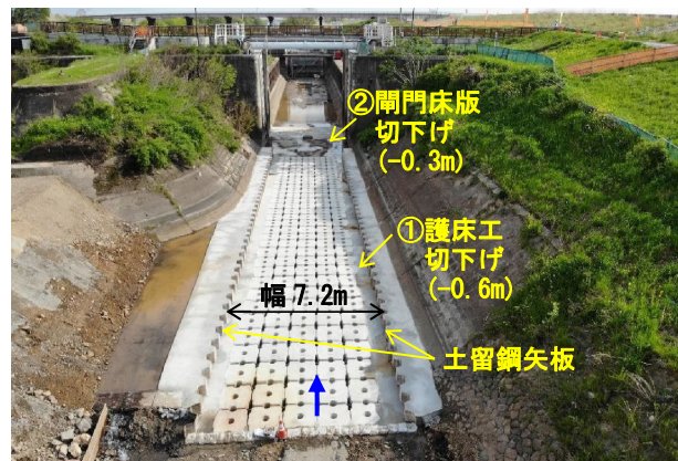
図-3 低水分派対策施工状況(上流側より望む)
