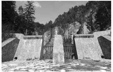
図10 ウゴヴィッツァに新設された土石流対策堰堤 (2016年、筆者撮影)
