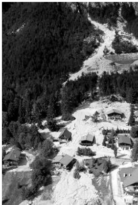
図9 マルボルゲットにおける土石流被害
