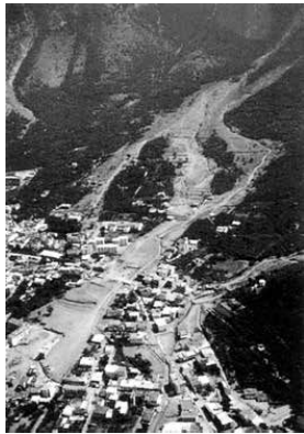
図7 サルノの土石流氾濫状況
