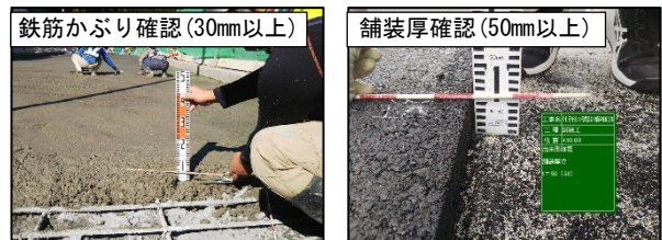
写真-6 施工管理厚さ確認状況
