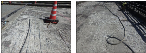
写真-5 床版上面状況(舗装全撤去時)
