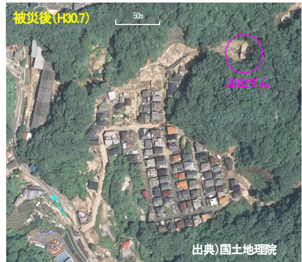
図-1 被災前後の状況（梅河団地）
