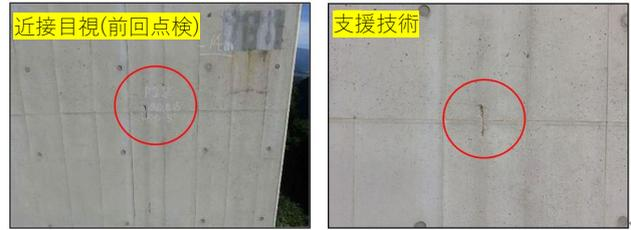
写真-8 はく離・鉄筋露出状況
