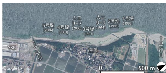
図-1 荒俣地先の離岸堤（1～5号堤）と人工リーフの配置
