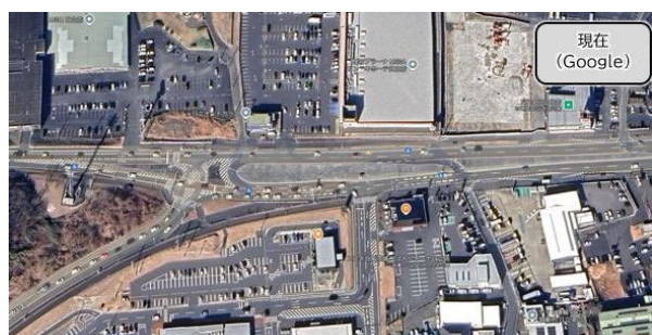
図-16 回転道路整備後の状況 (Google Mapsより)
