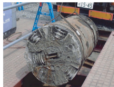
流域下水道幹線管渠推進工事 (岩手県)
