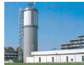
ニュータウン配水施設（東京都）
