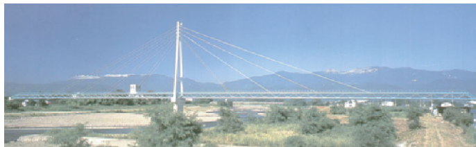
二径間斜張橋形式の水管橋（福岡県）
